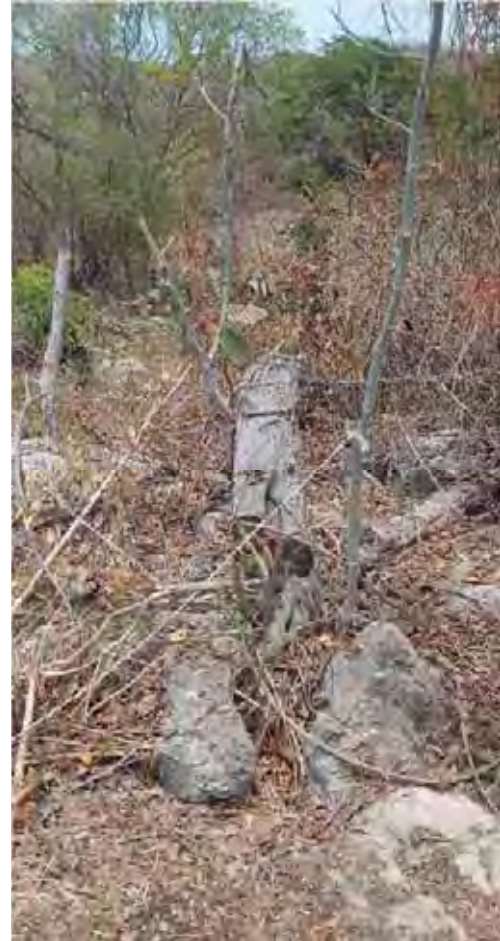
Figura 10 Postes improvisados con arboles y herramientas utilizadas para su instalación
