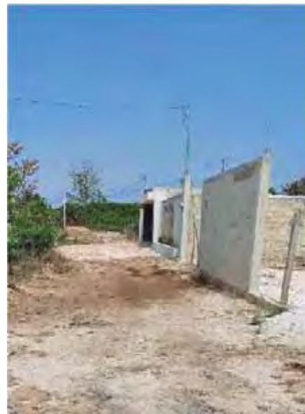
Figura 23 Viviendas en construcción
