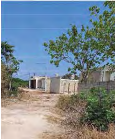
Figura 22 Viviendas en construcción
